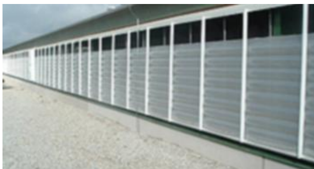
Рис. 5.7. Естественная вентиляция с надувными шторами
